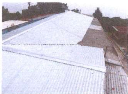
Foto 1. Finalizaacion del cambio techo Modulo 1.
