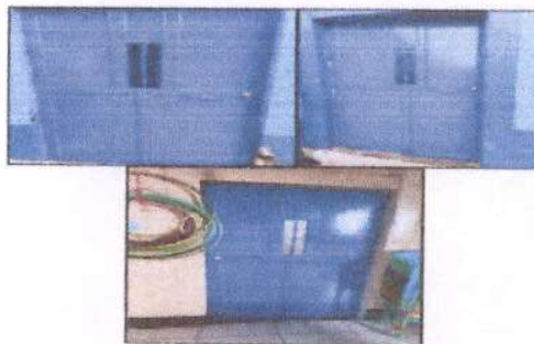
Foto 2. Finalización de puertas Modulos No. 1,2,3
