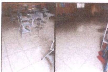
Foto 5. Finalizacion de piso Modulo 2.
