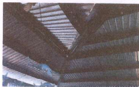
Foto4. Finalización de costaneras Aulas No. 2
