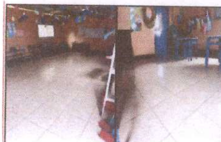
Foto 6. Finalización de piso Modulo No.1
