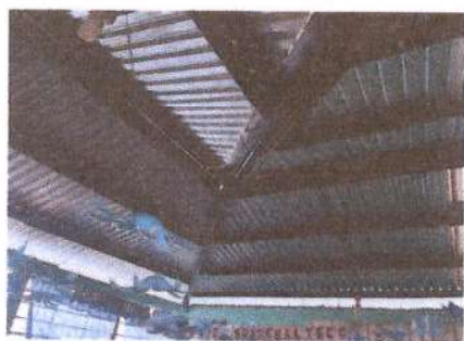
Foto 3. Finalización del cambio de costaneras Aula No. 1
